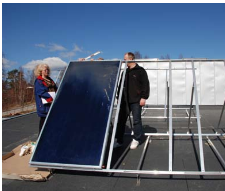
Camilla Landén från lokalförsörjningskontoret i Borås i färd med att granska uppsättningen av en första solfångare på Liljebergets förskola nu i maj.
